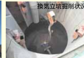
PR施設 (建設中)
