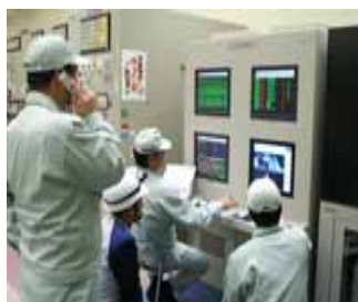
総合漏えい監視システム設置(改造工事) +ITVとの組合せ作動試験(確認試験)
