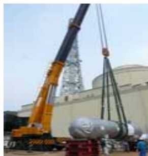
窒素ガスタンク据付工事
